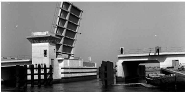
Afbeelding 2.1 De Westerwoldse Aa-brug in aanbouw in 1967, archiefphoto Rijkswaterstaat
