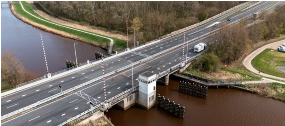
Afbeelding 2.2 Ontbreken van vluchtstroken op de Westerwoldse Aa-brug en op de toe- en afrit
